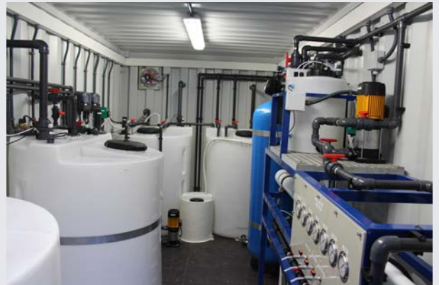
Interior del contenedor de Ósmosis Inversa
