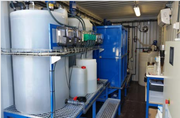
Interior del contenedor Físico - Químico
