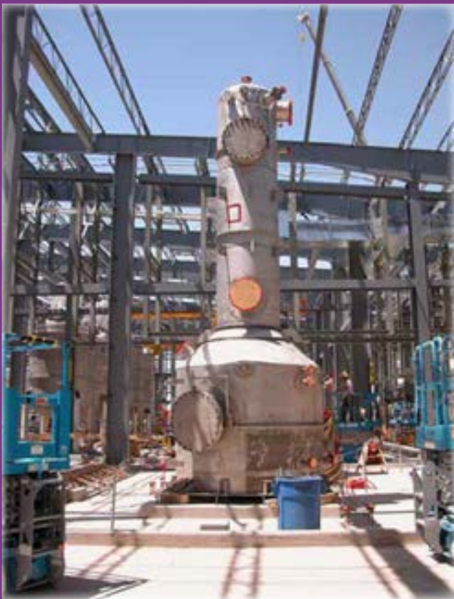
Planta de lavado de Gases (Scrubber)
