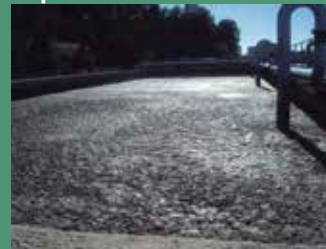
Lodos de depuradoras
