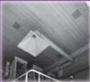
Campana Aspiració de gasos
