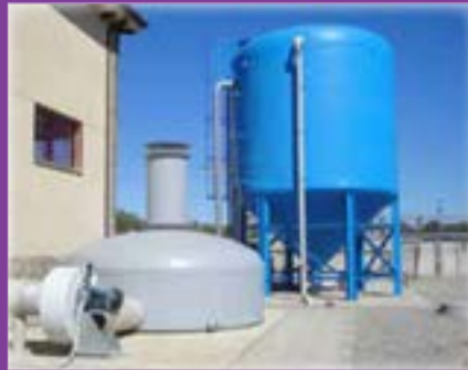
Equipo de desodorización de 7000 m³/h
