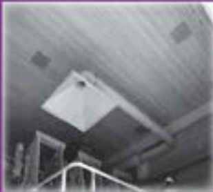
Campana aspiració de gasos
