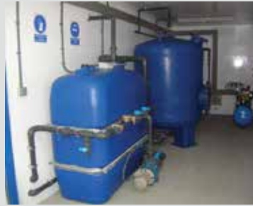
Equips de filtració 50m 3 /h
