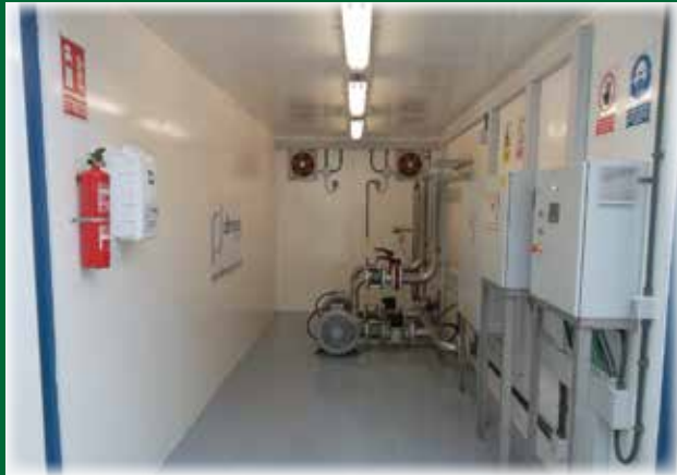
Central de Bombeig de Biogàs, vista interior
