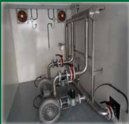
Sistema de captació del Biogàs
