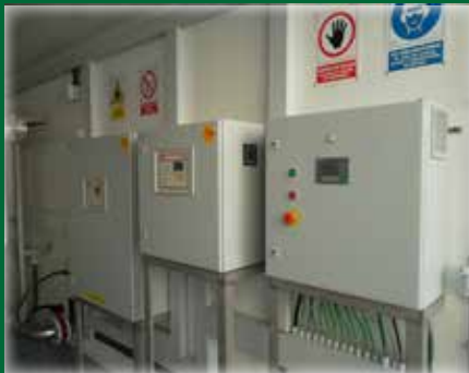
Analitzadors de Biogàs i Quadre General
