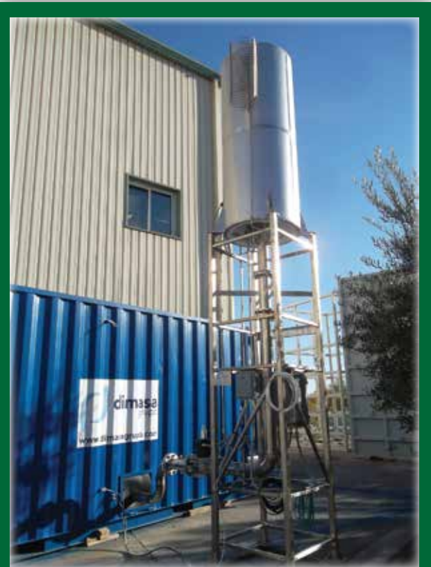
Central de Bombeig de Biogàs, vista exterior
