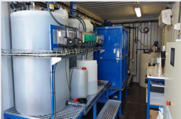
Interior del contenedor Físico - Químico
