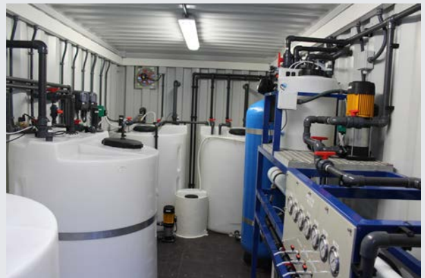
Interior del contenedor de Ósmosis Inversa
