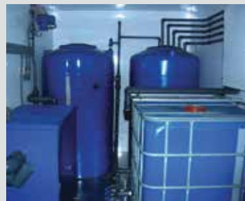
Equipos de bombeo 50m 3 /h
