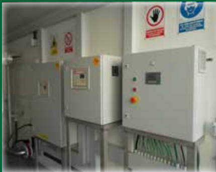
Analizadores de Biogás y Cuadro General
