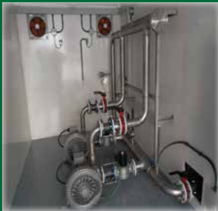
Sistema de captación del Biogás
