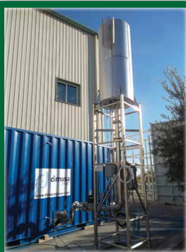
Central de Bombeo de Biogás , vista exterior
