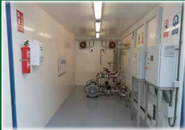
Central de Bombeo de Biogás , vista interior
